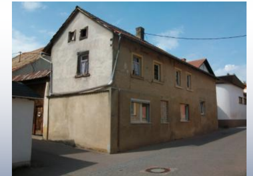
Gestörte Gliederung durch querformatige Fenster im Erdgeschoss, Weinbergstraße
