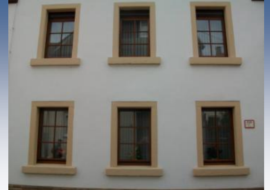
Ortstypische Fenstergestaltung bei Wohngebäuden....
