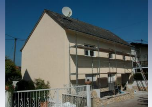
Besser: Anlage hinter First und in Dachfarbe
