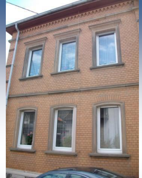
Klare Gliederung durch Fensterachsen und Sandsteinfriese, Störung der Harmonie durch ungegliederte Fensterscheiben
