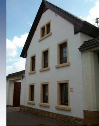
Klare Fassadengliederung durch senkrechte Fensterachsen, Schillerstraße
