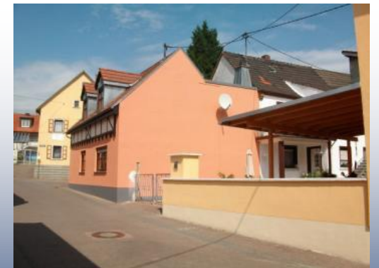
Besser: Anlage auf rückwärtiger Dachfläche
