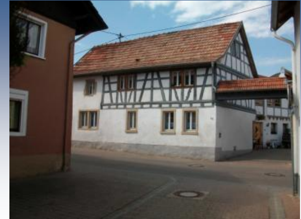
Fasadengliederung durch Sichtfachwerk und senkrechte Fensterachsen
